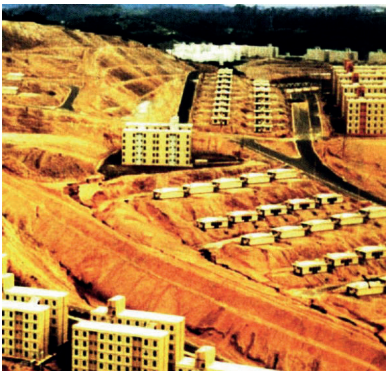
Imagens que mostram o desencontro entre projetos de terraplenagem e os potenciais processos erosivos e de assoreamento que irão provocar (foto de domínio público pelo critério de fair use ).
