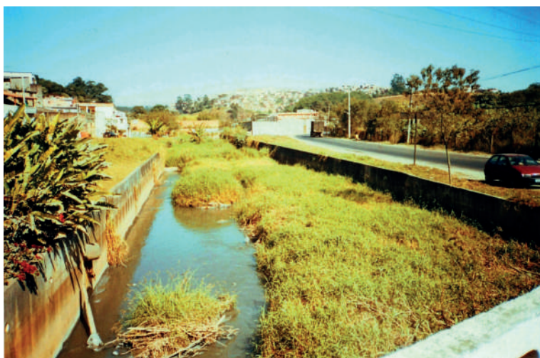
Assoreamento do Córrego Cabuçu de Cima, cidade de São Paulo, comprometendo sua capacidade de vazão em cerca de 80% (foto de domínio público pelo critério de fair use ).
