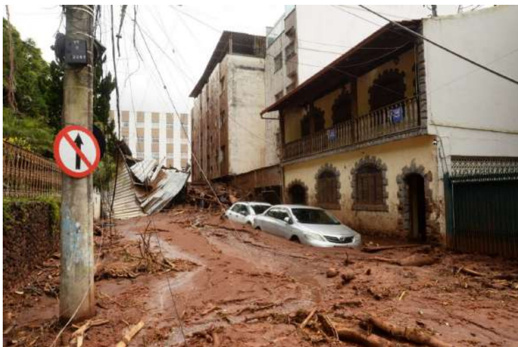
Enchentes e deslizamentos ocorridos em Juiz de Fora em fevereiro de 2026. Foto Túlio Santos-EM-DA Press.
