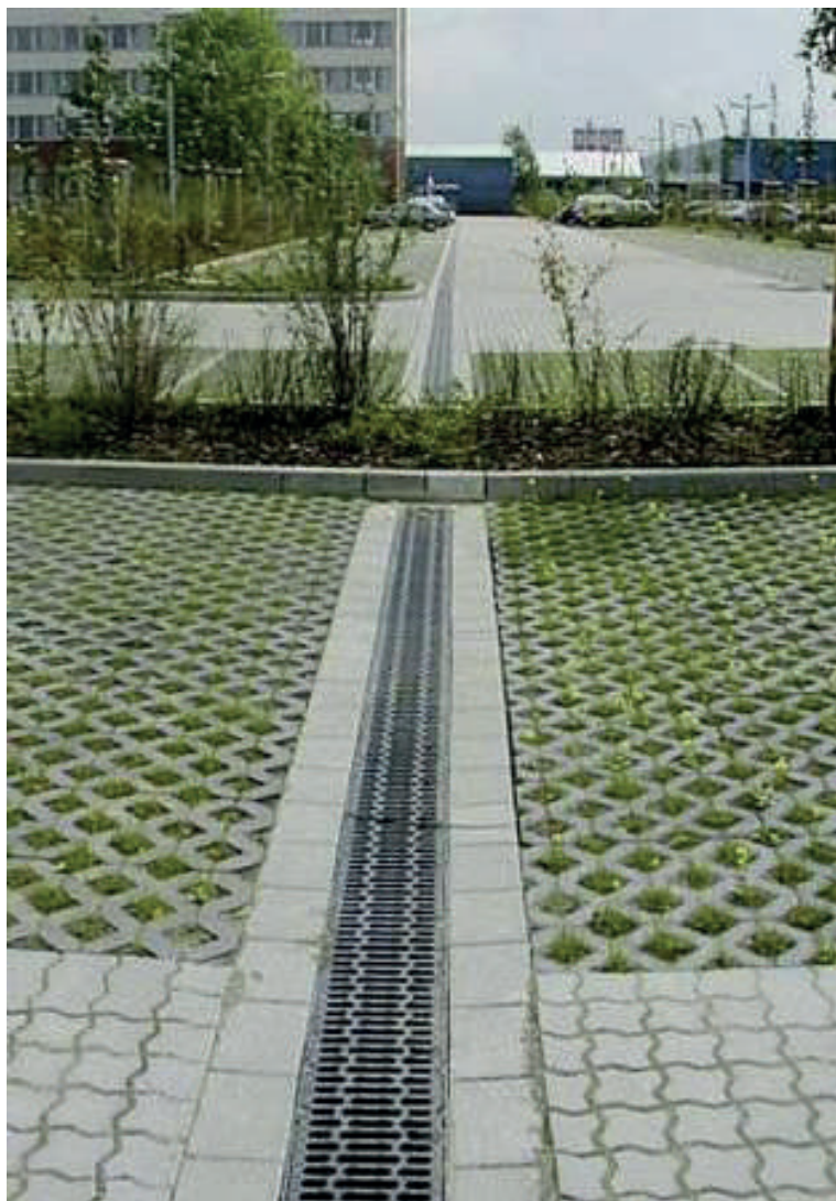
Exemplo de pisos drenantes. Funcionais além de esteticamente atraentes (foto de domínio público pelo critério de fair use ).
