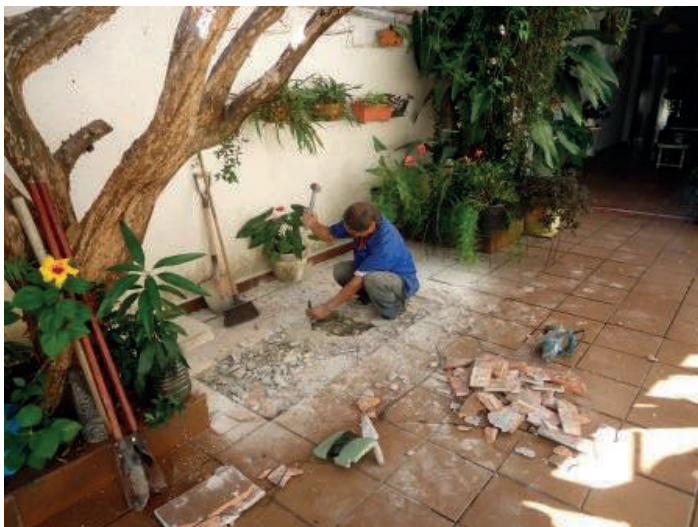
Trincheira drenante – fase executiva 1 – quebrando o piso (foto de domínio público pelo critério de fair use ).
