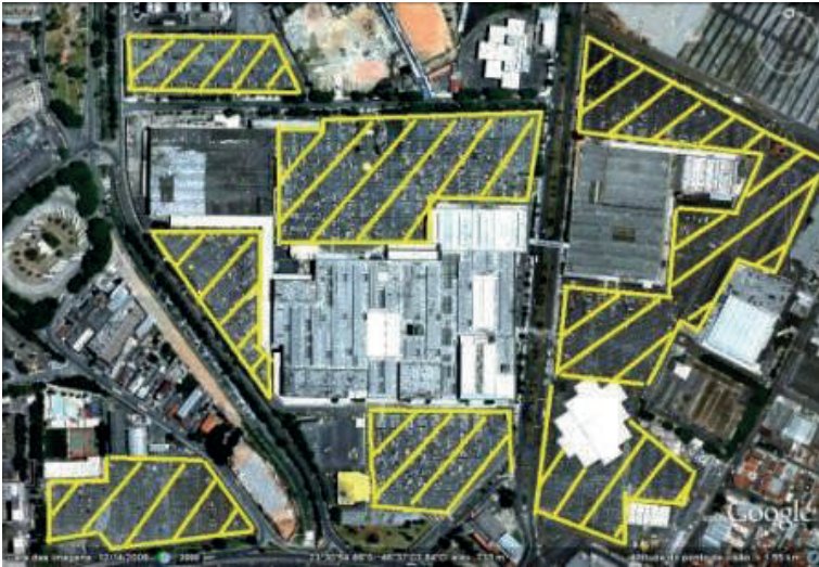
Extensas áreas impermeáveis associadas a um shopping center (foto de domínio público pelo critério de fair use ).
