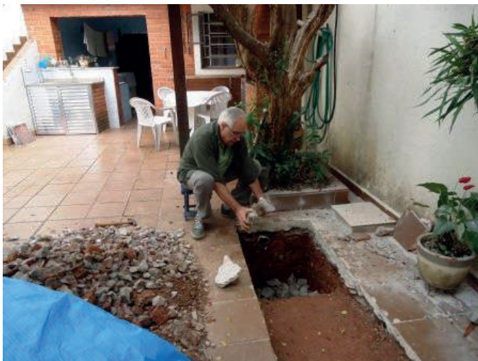
Fase executiva 2 – enchendo a vala aberta de entulho de construção civil bruto (foto de domínio público pelo critério de fair use ).
