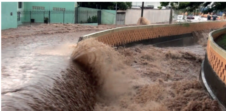
A cidade lançando um volume imenso de águas pluviais sobre um sistema de drenagem urbana progressivamente incapaz de lhe dar vazão. São Carlos – SP (foto de domínio público pelo critério de fair use ).
