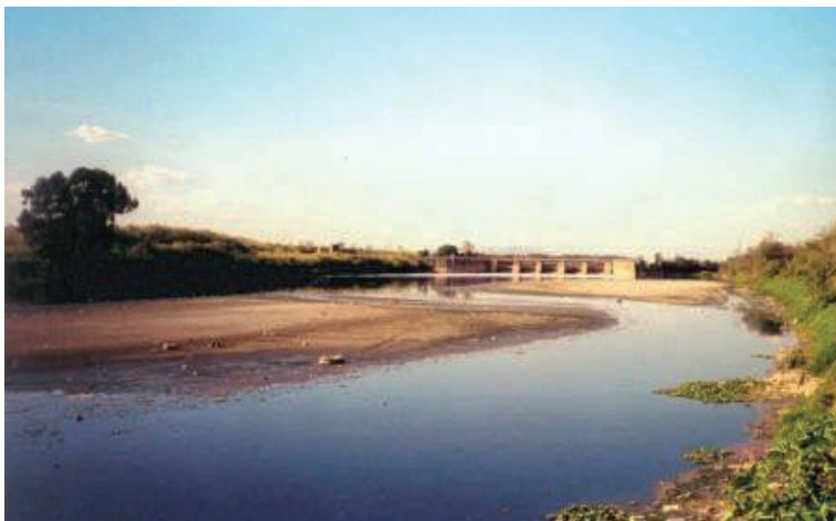
Bancos de assoreamento na calha do rio Tietê – Região Metropolitana de São Paulo (foto de domínio público pelo critério de fair use ).
