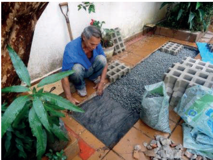
Fase executiva 3 – acabamento com colocação da manta geotêxtil, pedrisco de brita e peças vazadas de concreto (foto de domínio público pelo critério de fair use ).
